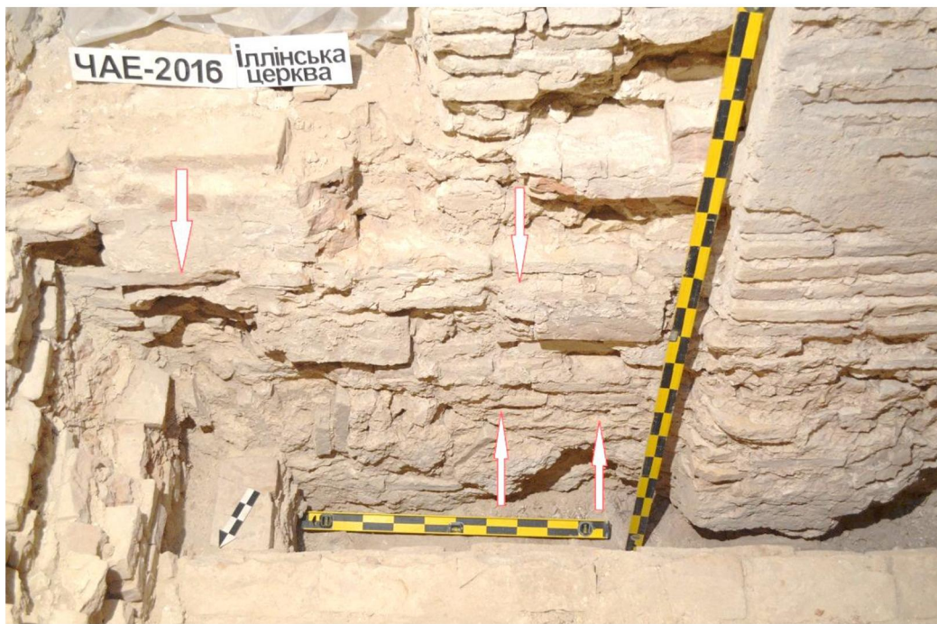
Мал. 5. Ділянка північного фасаду Іллінської церкви нижче входу на хори (фото 2016 р.).
