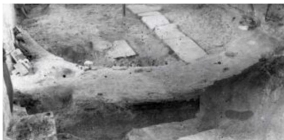
Ил. 7. Пірофілітові плити, покладені у вигляді двох доріжок під лаги дерев'яної підлоги у центральній абсиді Борисоглібського собору. – Національний архітектурно-історичний заповідник «Чернігів стародавній». Фотодокументальний фонд. КН-152/39, Ф-1-7.
