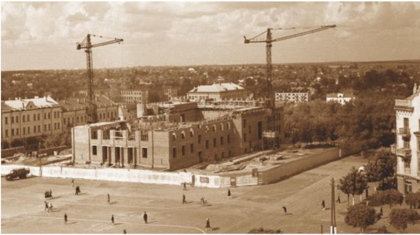
Фото 5. Будівництво драмтеатру, 1958 р. 41
