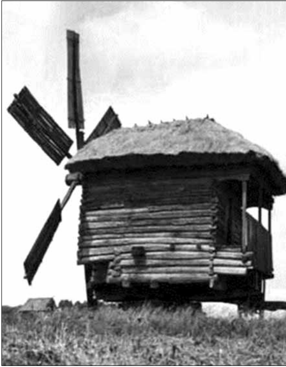
Вітряк — с. Лісове, Ніжинський р-н, Чернігівська обл., кінець XIX ст. Корпус зведений на масивних підвалинах («братах») у зруб з соснових та вільхових плах, зі стовпом зв'язаний «братами» і масивною балкою («бабою»), врубаною в корпус на рівні високо розміщеної підлоги. Перед дверима — піддашок на стовпцях. Дах трисхилий, на кроквах, критий соломкою. Споруда подібна до поширеної на Чернігівщині традиційної комори, в якій розміщено обладнання з валом, крилами та колесом, «баклушею» з веретеном, кошем, жорнами на помості, скриненю для борошна. Мішки з зерном подавали на піддашок воротом. Місцева назва — «млинок».
