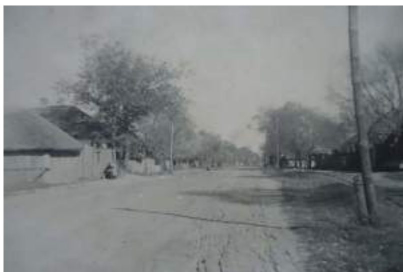
1950 рік. Центральна дорога.
