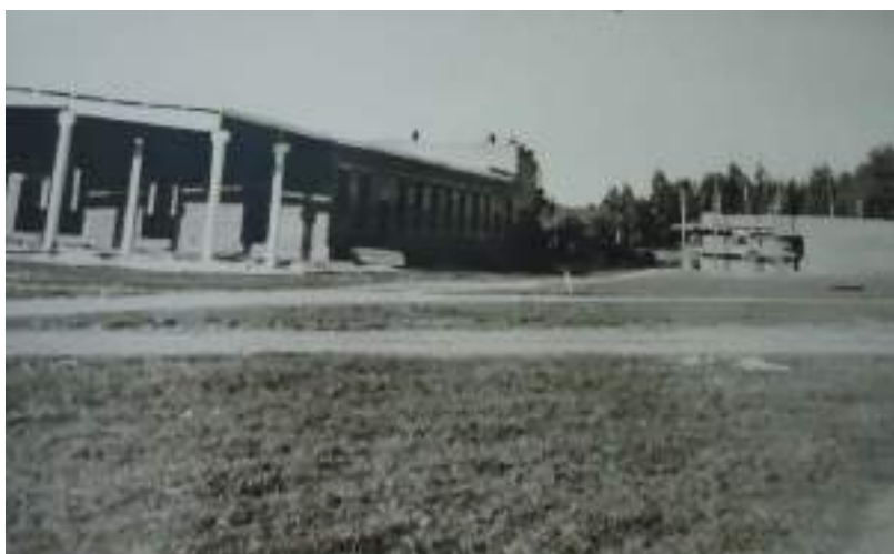
Консервний завод у стані будівництва.
