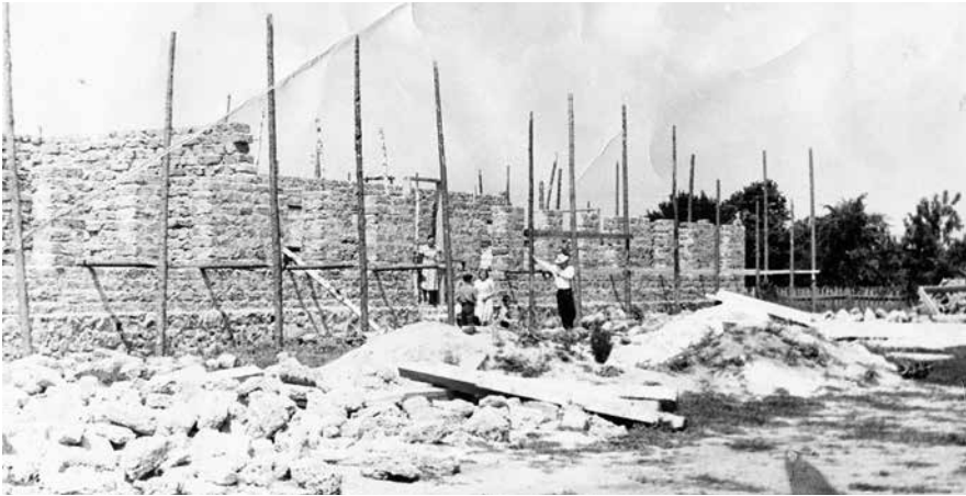
Будівництво нового шкільного приміщення. 1964 р.
