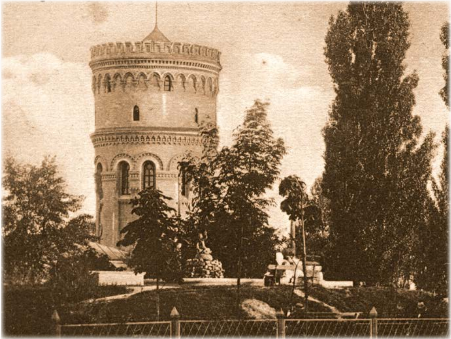
Чернігів. Водонапірна башта 1897 – 1898 рр. (не збереглася)
