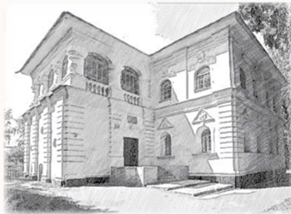
Будинок канцелярії Київського полку (м. Козелець, 1756 – 1765 рр.)
